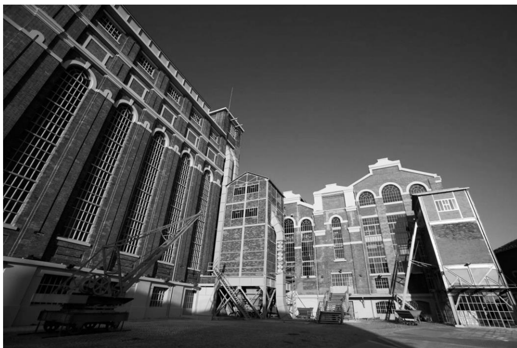
Fig. 5 — Central Tejo, imagem retirada de https://portugal.edp.com/pt-pt/noticias/2016/06/30/central-tejo-renova-se . [Consult. 20 ago. 2020].
