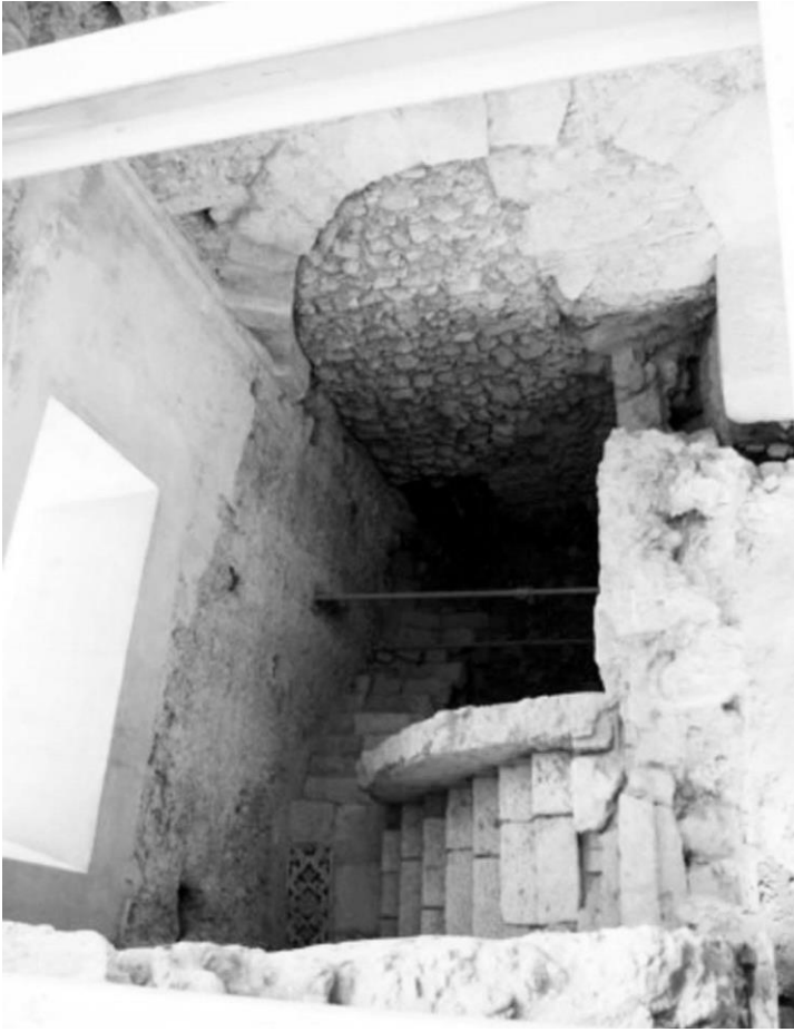
Fig. 7 — Vista geral de estruturas de uma casa construída antes do terramoto de 1755, que se encontra no Museu de Lisboa — Teatro Romano (foto do autor, 2011).
