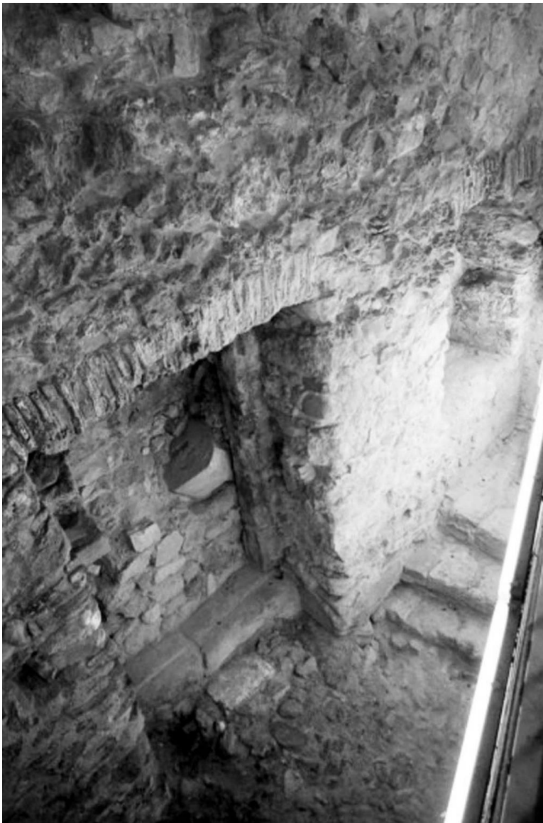
Fig. 6 — Interior da fachada de edifício encontrado no Largo da Sé (foto do autor, 2019).
