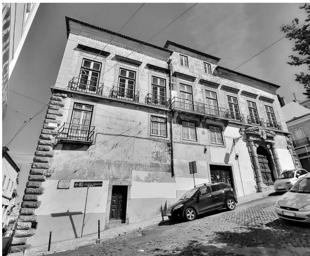
Fig. 1 — Vista geral do Palácio dos Condes de Figueira, no Largo Rodrigo de Freitas, junto à esquina do qual ficava uma das portas da Muralha Fernandina, o Arco de Santo André (do lado esquerdo da imagem) (foto do autor).
