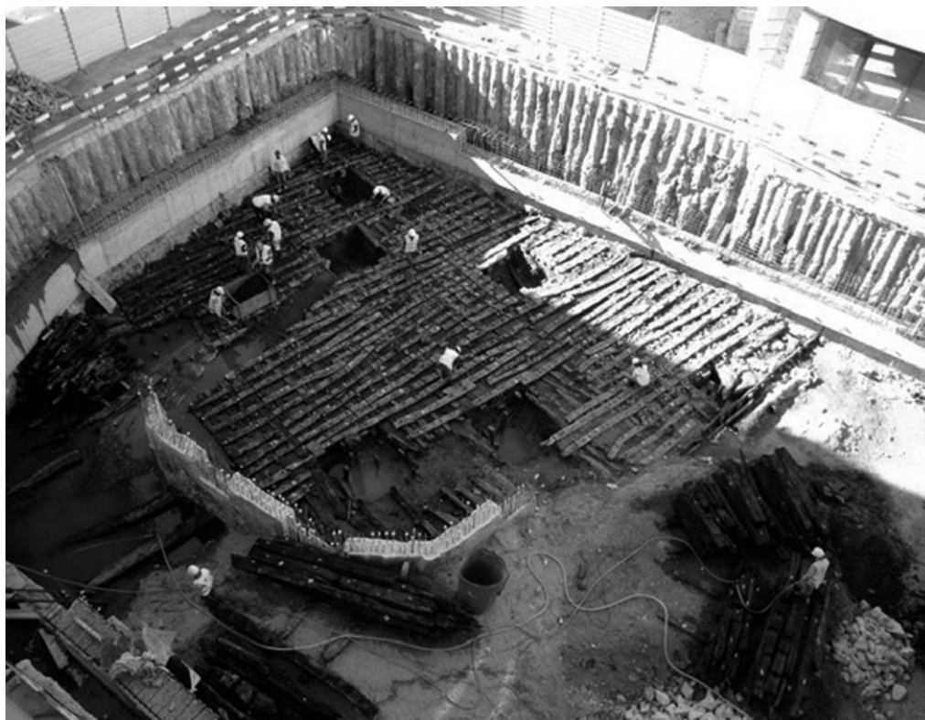
Fig. 3 — Descobertas na Praça D. Luís. Grade de maré construída com peças de antigos navios e que estaria associada aos estaleiros navais da Ribeira das Naus (cortesia de Alexandre Sarrazola).
