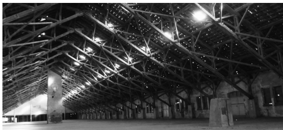
Neuengamme — Fábrica de tijolos (interior)
