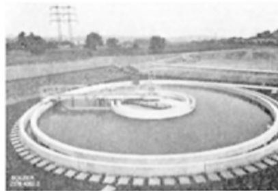
Fig. 3—Floculador das lamas
