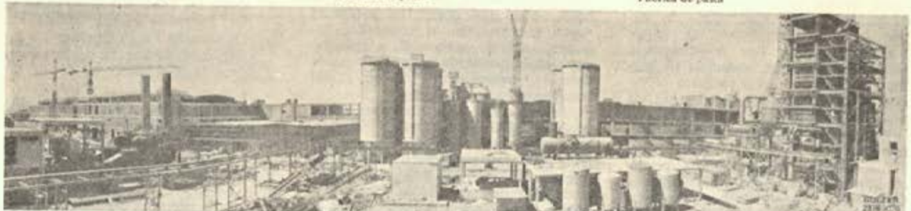
Instalação de turbina a gás
