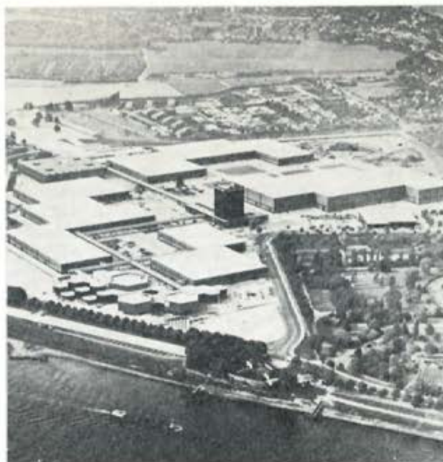
Aspecto geral das novas instalações
