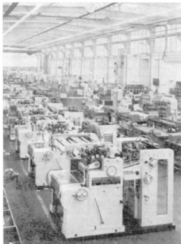
Linha de montagem da Rotafolio II a uma cor, de impressão directa
