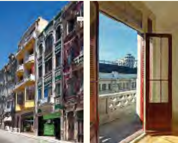
← Final. Fachada à rua e espaço interior do 2.º andar depois da intervenção. Atente-se ao trabalho decorativo interior (pavimentos, paredes e tetos) e exterior integralmente recuperados na sua expressão original - o que não seria possível introduzindo isolamento térmico pelo interior ou exterior.
