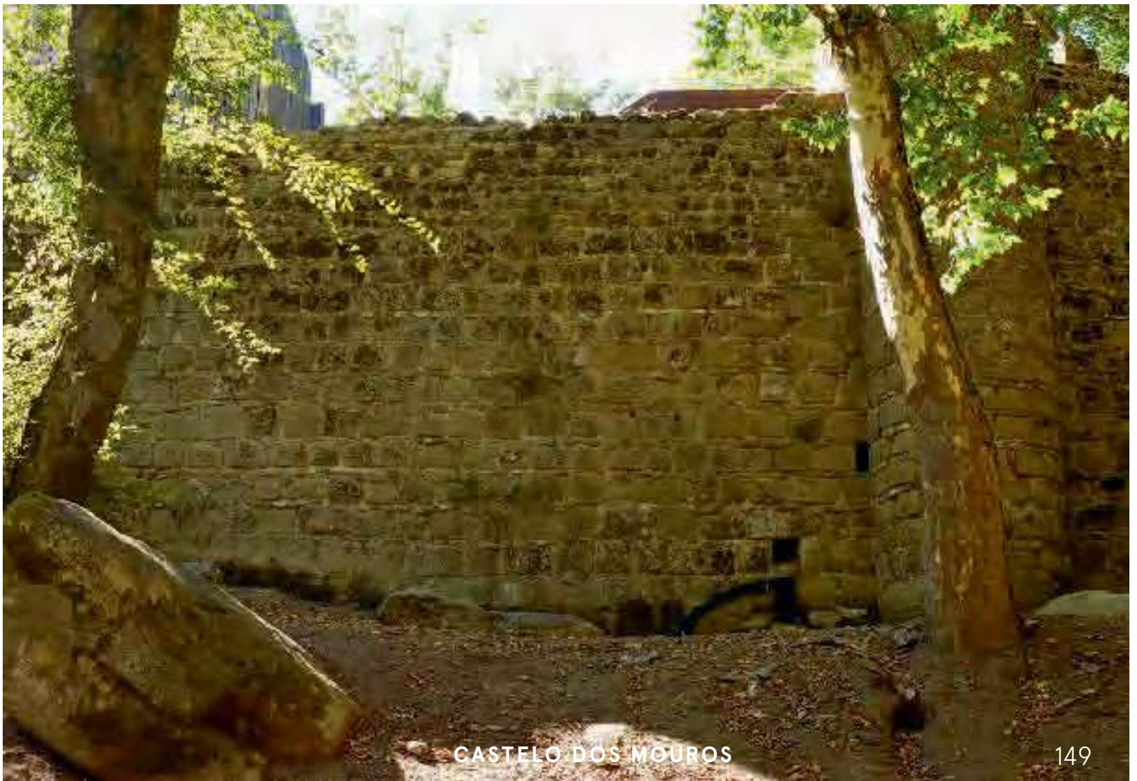
No exterior da cisterna, paredes e respiradouros, adotou-se também a metodologia de restauro das muralhas, e, no seu interior, procedeu-se unicamente à limpeza das paredes e pavimento, bem como à limpeza e consolidação do revestimento da abóbada.
