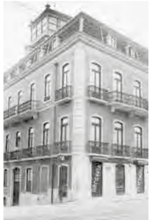
A Drogaria Progresso, que pertencia ao pai de Orlando Ribeiro, situada na Rua da Escola Politécnica perto da residência deste e da Imprensa Nacional, era um local privilegiado para permuta de textos e troca de mensagens entre os dois amigos.
